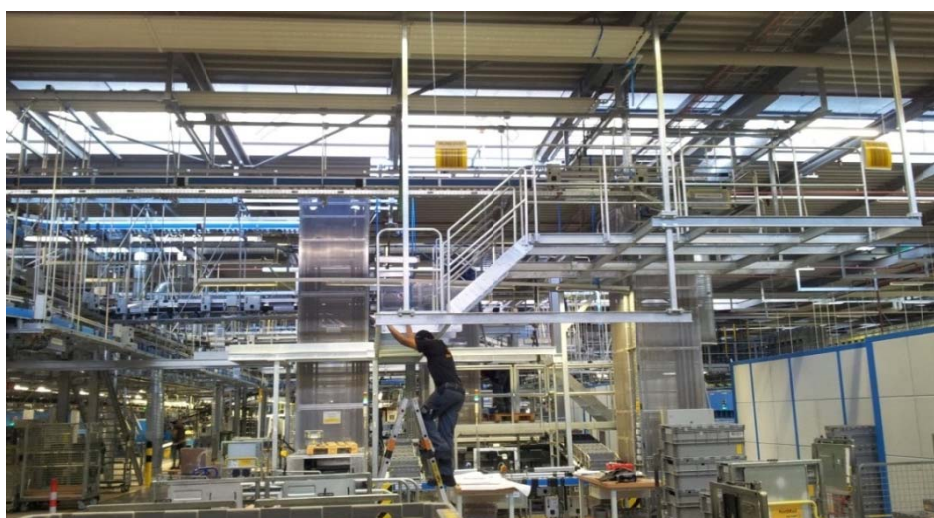
Montage der vorgefertigten Podest-Elemente
