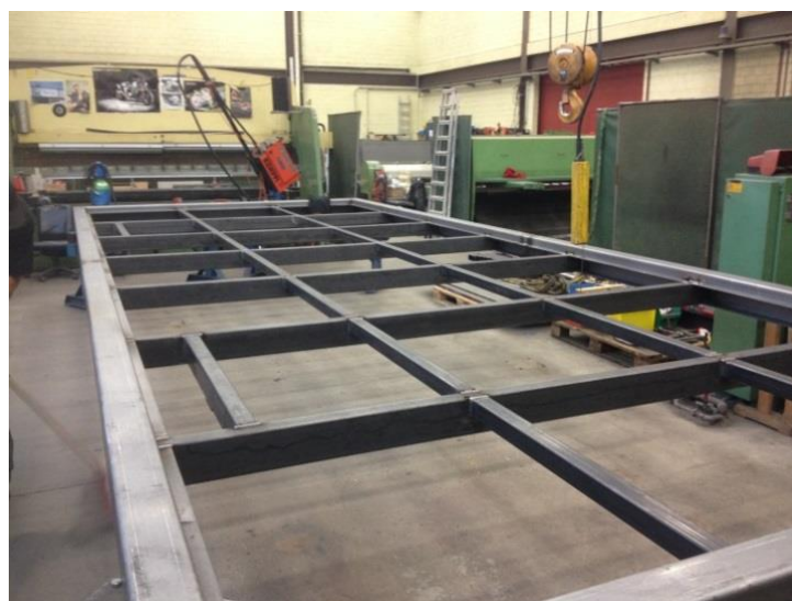
Fertigung Deckelement in der Schlosserei
