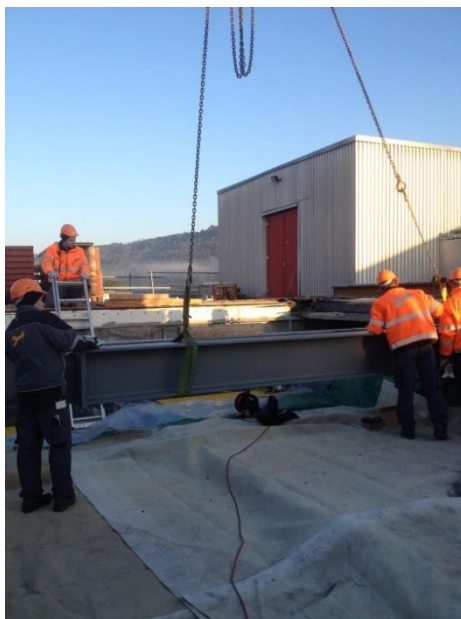
Einbringen der Träger
