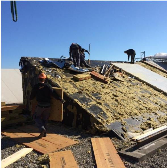
Demontage der bestehenden Elemente
