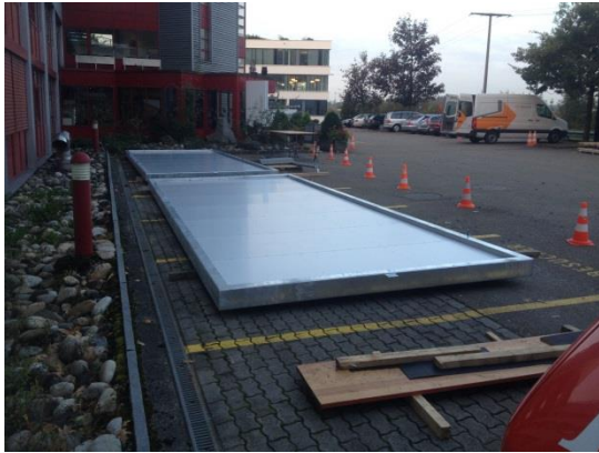
Zusammenbau Deckel vor Ort
