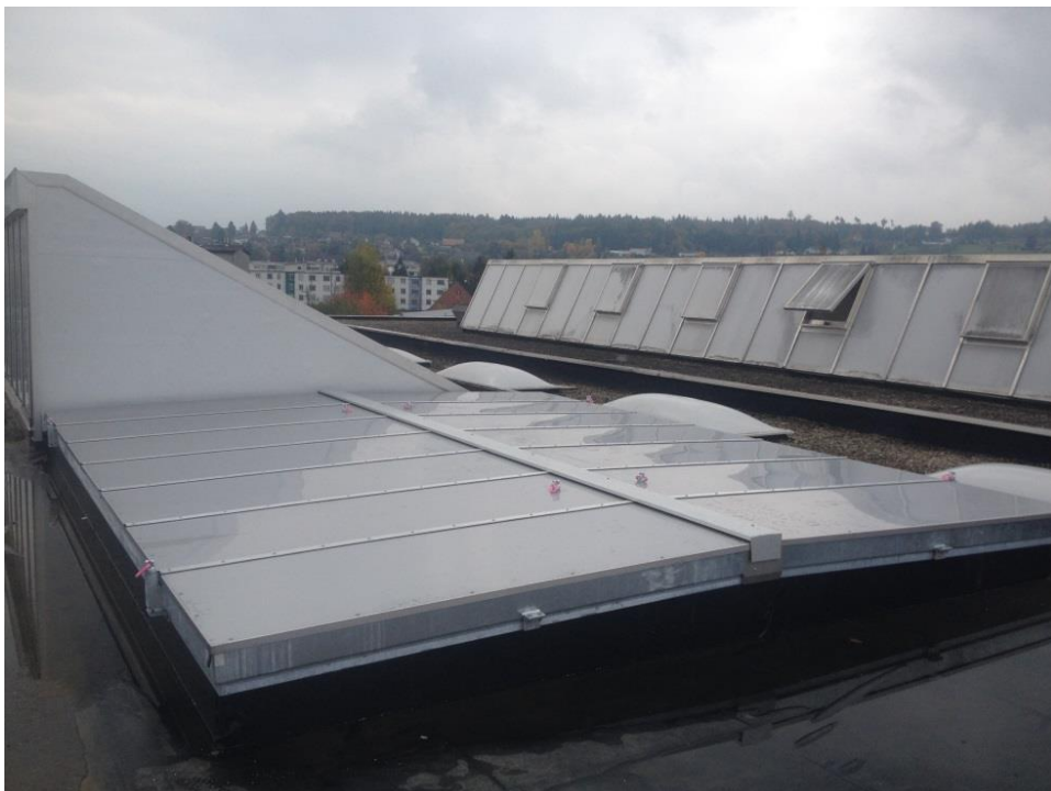
Fertig montierte Dachöffnung in geschlossenem Zustand
